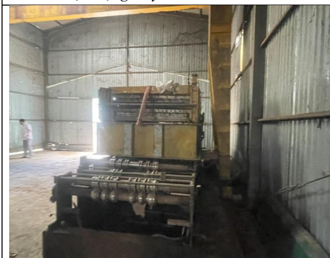
5. Hiện trạng cầu trục
