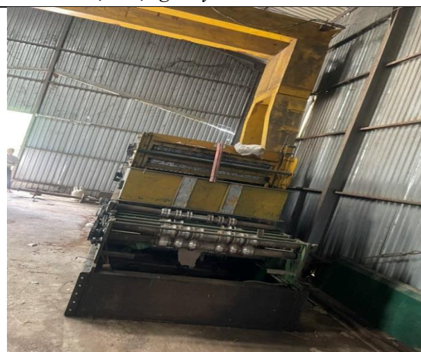
6. Hiện trạng cầu trục
