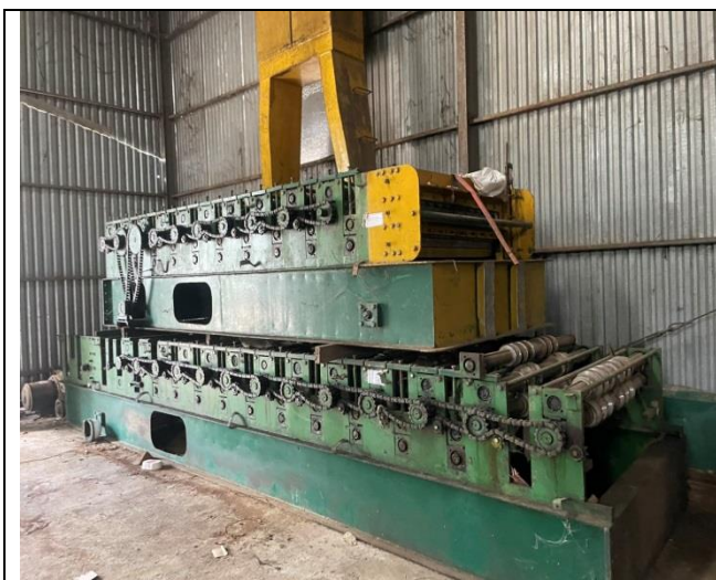
1. Hiện trạng cầu trục
