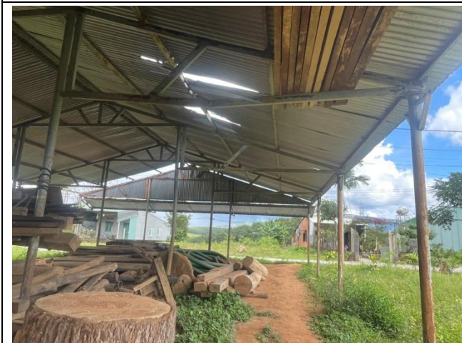
3. Hiện trạng nhà xưởng
