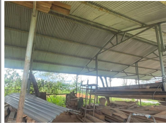
1. Hiện trạng nhà xưởng gỗ
